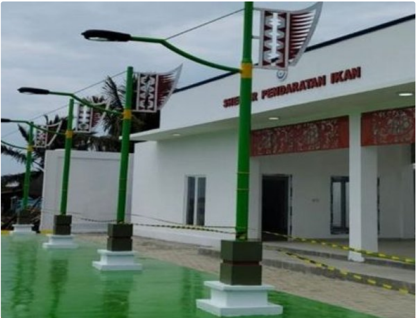
Pembangunan Kampung Nelayan Merah Putih Ciwaru Masuki Tahap Akhir
